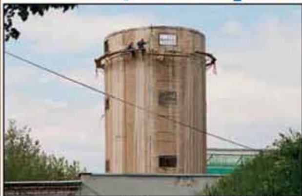
Такой была водонапорная башня 3 июня 2011 года
