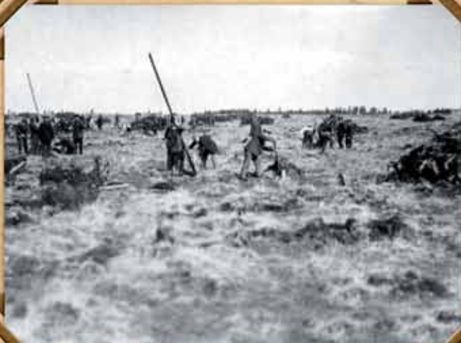
Корчевание пней на территории строительства завода. 1930 год.
