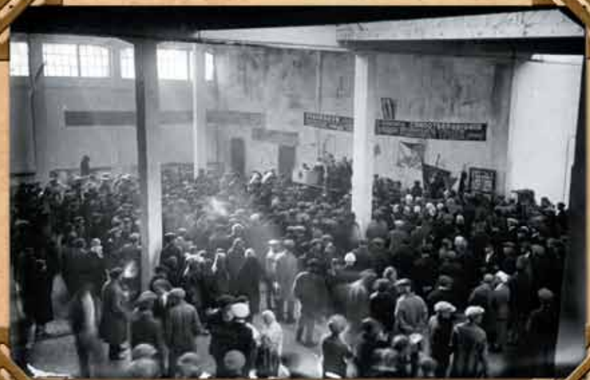
Митинг в цехе №3 по поводу окончания его строительства
